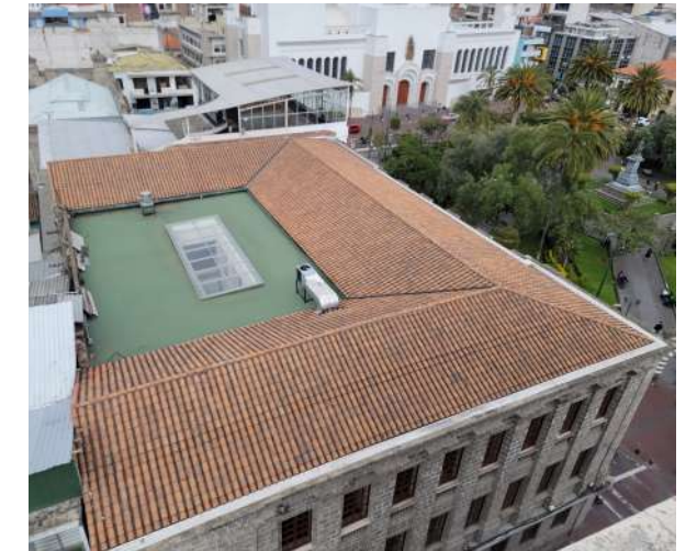
Figura 40. Cubierta del Palacio Municipal
