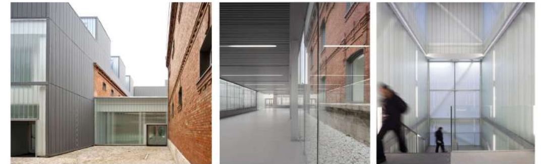
Arquitectura moderna y ligera. Rehabilitación de una nueva arquitectura. Condiciones - Nueva imagen. Grandes lucernarios de vidrio. Inserción de luz. Centro neurálgico y distribuidor de los usos.
