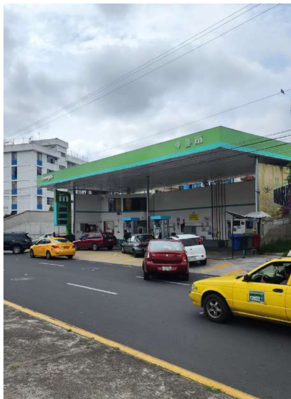
Fotografía 4 Registro fotográfico Gasolinera Av. Bolivariana
