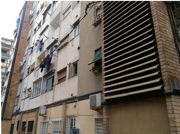
Figura 7 Fachadas de bloques de La Verneda.
