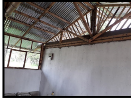
Figura 87. Detalle de cercha traslúcida
