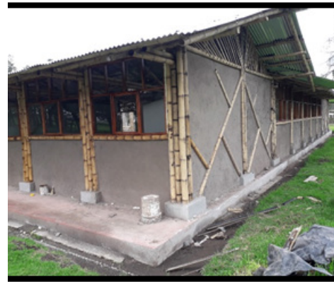
Figura 83. Vista 1 de paredes fraguadas, ventanas instaladas e instalado la cubierta
