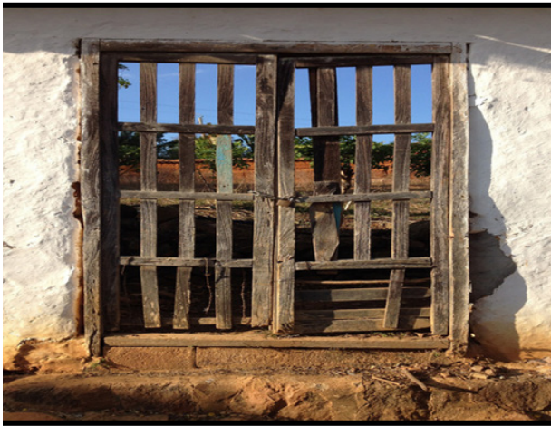
Figura 17. Bahareque, una técnica constructiva sismo resistente en Colombia
