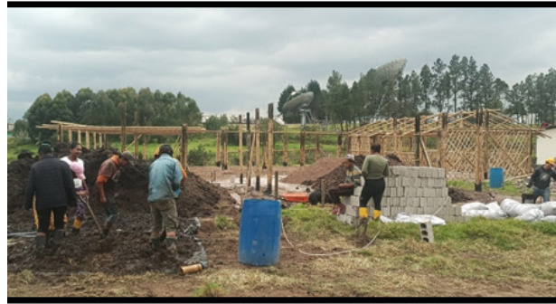
Figura 80. Vista ampliada de proceso constructivo
