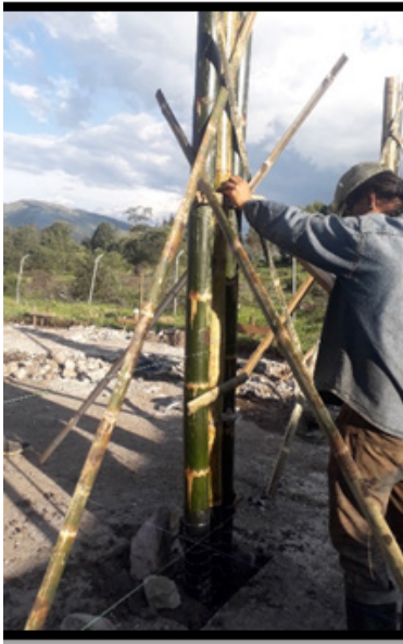
Figura 75. Levantamiento de pilares en caña guadúa
