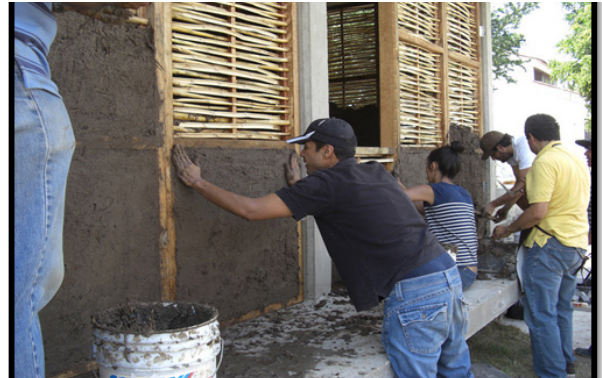
Figura 13. Bahareque, una técnica constructiva sísmo resistente en Colombia
