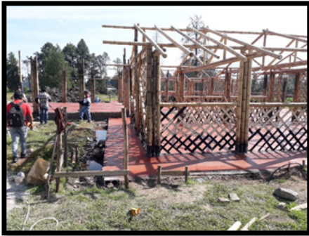
Figura 78. Detalle de antepecho en caña guadúa
