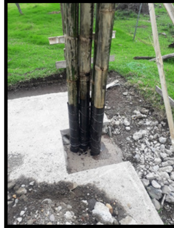
Figura 76. Detalle de anclaje entre las columnas de palo de caña guadúa con la cimentación
