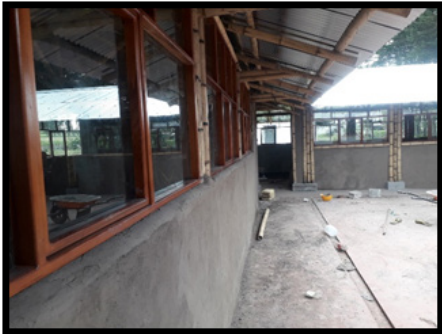
Figura 86. Detalle de ventanas, aleros y acabado de paredes
