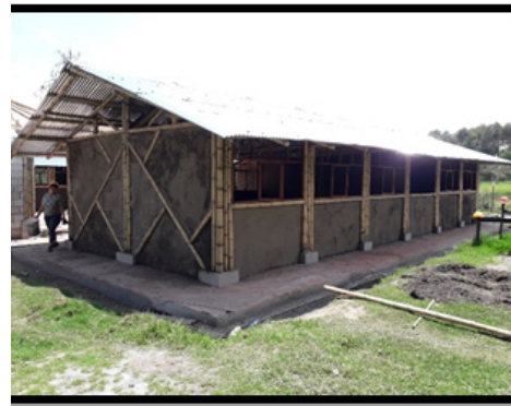
Figura 84. Vista 2 de paredes fraguadas, ventanas instaladas e instalado la cubierta
