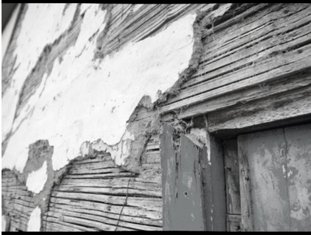
Figura 11. Bahareque, una técnica constructiva sísmo resistente en Portoviejo
