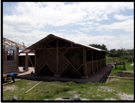
Figura 85. Vista 3 de paredes fraguadas, ventanas instaladas e instalado la cubierta
