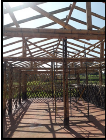
Figura 77. Armado de cerchas de caña guadúa
