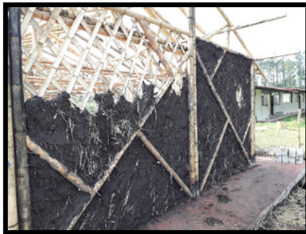
Figura 82. Detalle 2 de elaboración de paredes mixtas bahareque – caña guadúa
