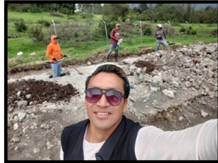
Figura 74. Excavación para cimientos
