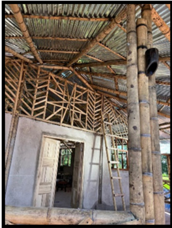
Figura 92. Vista de detalle en entrada al proyecto
