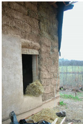
Figura 7. Construcción con paja
