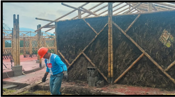
Figura 81. Detalle 1 de elaboración de paredes mixtas bahareque – caña guadúa
