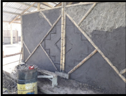
Figura 89. Proceso de adición de cruz chacana en paredes
