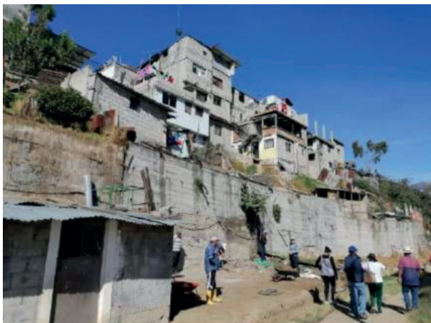
Fig. 1: Vivienda en zona de riesgo quebrada en Lumbisí Fuente: PACHA estudio
