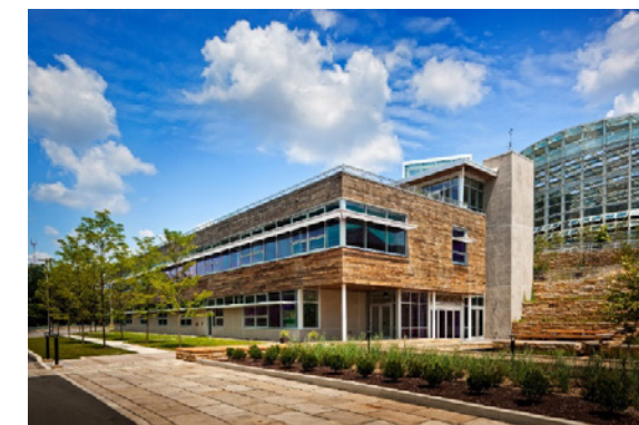
Figura 38. Vista general de la intervención. Fuente: Denmarsh Photography, 2021
