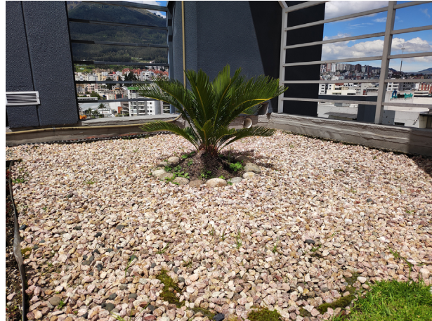
Figura 51. Uso de grava para filtrar el agua mas rapido Fuente: Elaboración propia, 2023.
