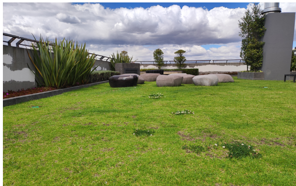
Figura 57. Vista general de la cubierta.
