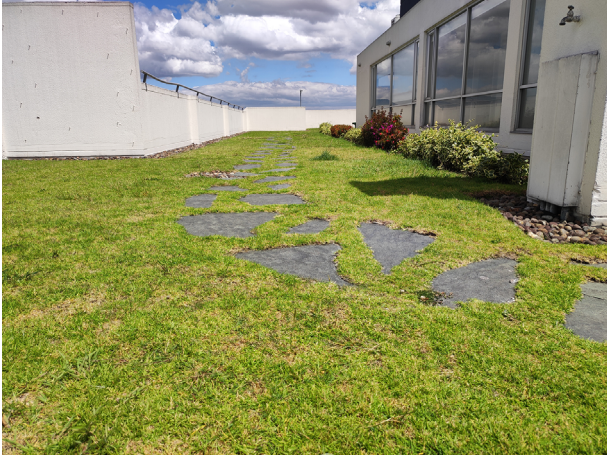
Figura 41. Vista general de cubierta verde del edificio Shyris Parc.
