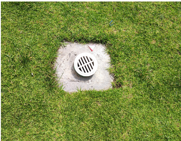
Figura 62. Sumidero ubicado al nivel de la capa vegetal.
