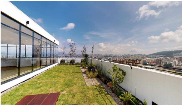
Figura 74. Cubierta con jardinera y grava perimetral. Fuente: Alvarez Bravo constructores, 2023.
