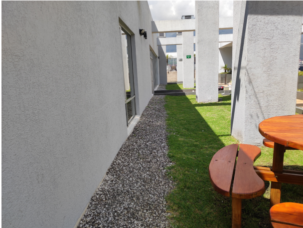
Figura 77. Uso de grava perimetral para el filtrado de agua. Fuente: Elaboración propia, 2023.
