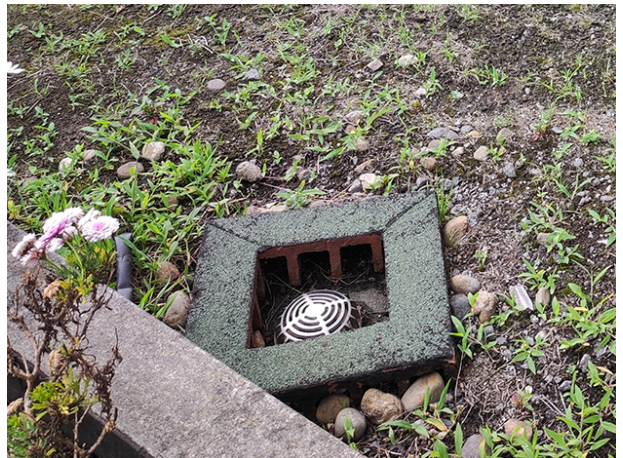
Figura 72. Sumidero ubicado al nivel del geodren. Fuente: Elaboración propia, 2023.
