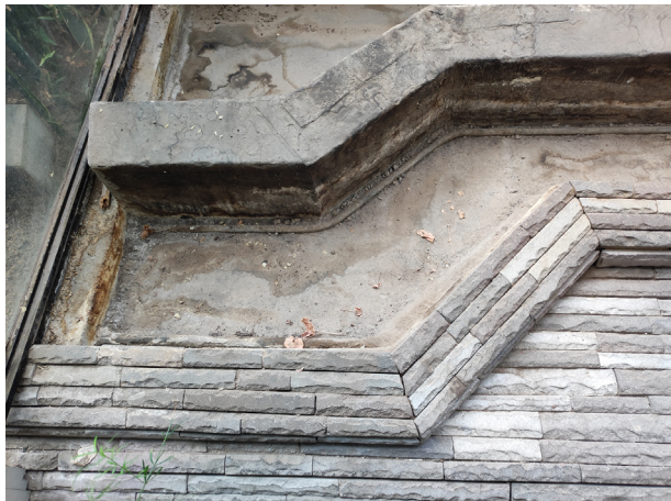
Figura 65. Deterioro de la estructura y sistema de riego. Fuente: Elaboración propia, 2023.
