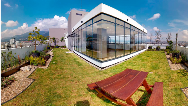
Figura 73. Visual general de la cubierta. Fuente: Alvarez Bravo constructores, 2023.
