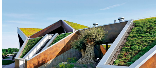
Figura 19. Aplicación de cubierta verde en Alemania. Fuente: ADD GREENproject, 2023).
