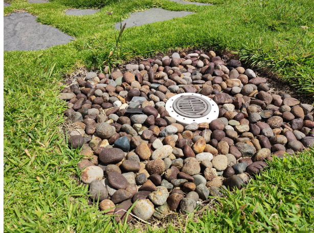
Figura 43. Sumidero ubicado dentro de grava.
