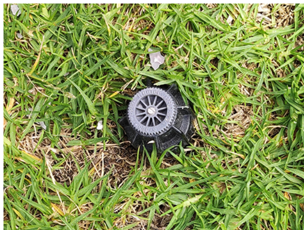
Figura 64. Aspersor con sistema automatico de riego.
