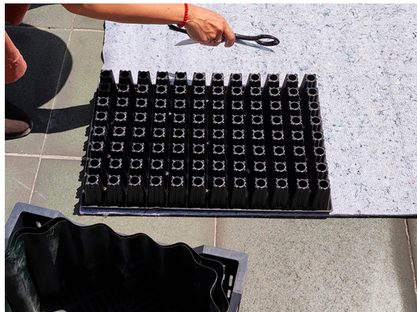
Figura 91. Corte del fieltro con la medida exacta. Fuente: Elaboración propia, 2023.
