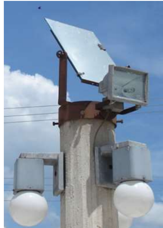
Figura 101. Foto del reflector solar. Se observa el espejo y el dispositivo de ajuste- sujeción y que permite el emplazamiento exacto de la superficie reflectante para el logro de la iluminación de la escultura. El sencillo mecanismo permite movimientos de rotación horizontal y vertical y “arriba-abajo” en dos sentidos haciéndolo apto para ser colocado en la posición que por diseño se ha determinado por los cálculos astronómicos y ópticos. Los ángulos de altura solar y acimutal fueron capitales en la concepción de este aparato.
