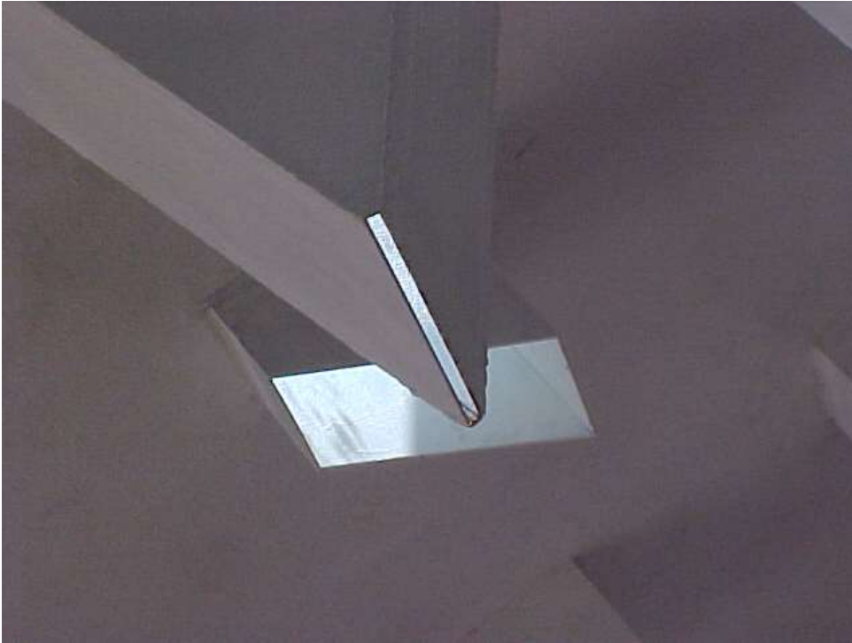
Figura 109. Tragaluz del calendario, véase la entrada de luz por la arista inferior. Detrás, un tragaluz ordinario. La luz que pasa por esta abertura incide en un rótulo esculpido en la escala del calendario con la fecha prevista y a la hora predeterminada. Todos estos conductos están protegidos por cristales transparentes que evitan el paso del agua, polvo, insectos o cualquier otro elemento indeseable dentro del memorial.
