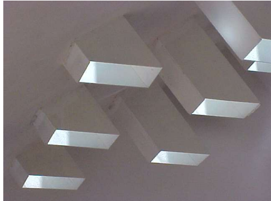
Figura 111. Cuando no entran los haces de luz en forma directa, los tragaluzes la difunden. En los días notables la radiación se proyecta en las láminas convenientes, por ejemplo, el 28 de enero. Se observa en esta foto, además, que no siempre la luz incide plenamente por toda la sección del conducto de luz, pero ello propicia un incremento de la iluminación interior cualquier día del año en el momento de la culminación solar para lograr un efecto sobrecogedor y místico en el interior del memorial.
