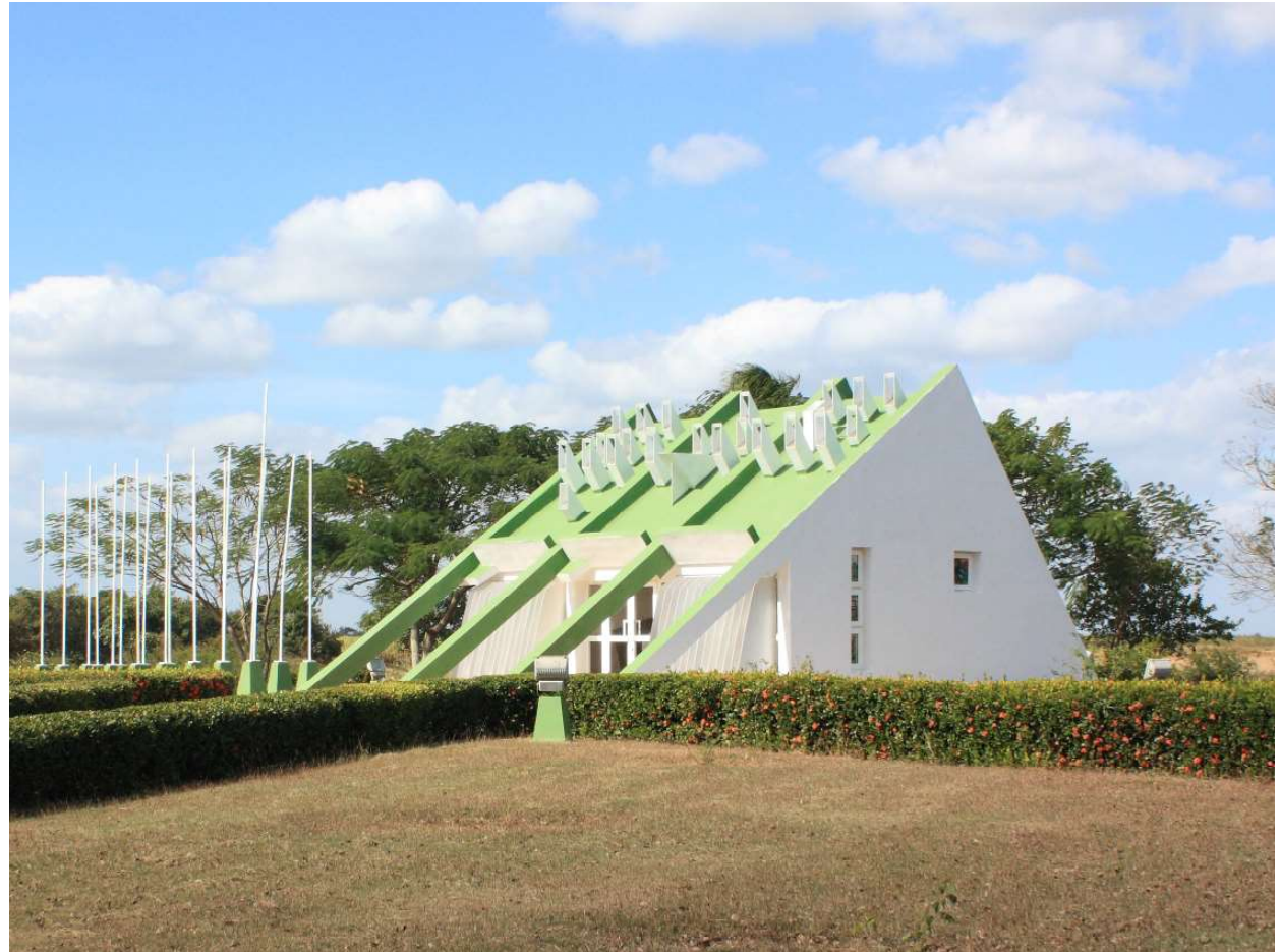
Figura 106. Vista general del Memorial Caimito de Hanábana dedicado a conmemorar la estancia de José Martí en el lugar cuando era un niño y donde escribió su primera carta conocida. La forma de la edificación la ha definido la incidencia solar del 23 de octubre en el momento de la culminación solar a las 12:07 horas. Se pueden observar en la cubierta sur del edificio los tragaluces que producen este efecto.
