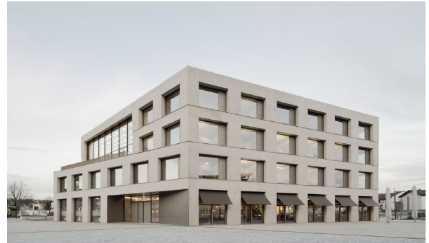
Fig. 9. Situación actual CITY HALL REMCHINGEN Fuente. 9. ARCHDAILY/Gonzalez
