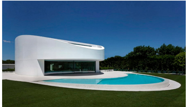
Fig. 12. Distintas formas y técnicas de construcción con hormigón Fuente. 12. Tovar Marco, 2018
