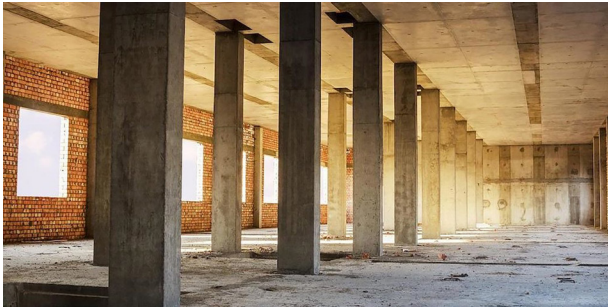
Fig. 11. Elementos estructurales con hormigón Fuente. 11. Cemix, 2018
