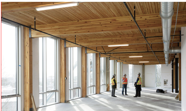
Figura 10. Madera laminada en estructuras Fuente: Svensktlimtra (2014)
