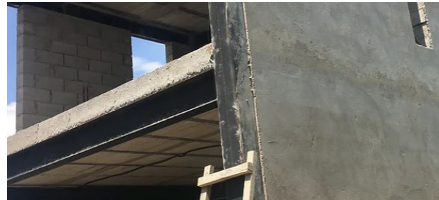
Figura 68: Pared de bloque de hormigón enlucida. Fuente: Techart, (2023).
