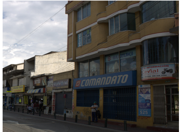
Figura 86. Observación - Cerramientos en planta baja
