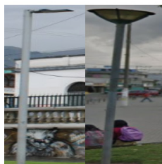
Tipo: Luminaria Simple Materialidad: Metal / Concreto Tamaño: h= 8 m
