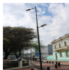
Tipo: Luminaria Doble Materialidad: Metal Tamaño: h= 12 m
