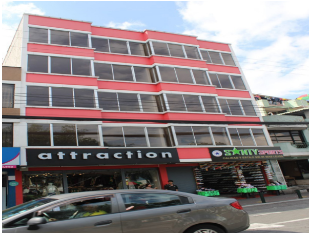
Figura 85. Observación - Cerramientos en planta baja
