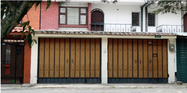
Figura 60. Observación - Cerramientos en planta baja
