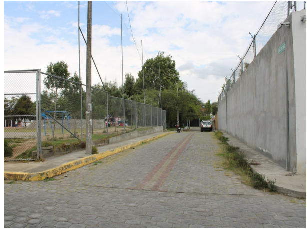
Figura 110. Observación - Cerramientos en planta baja
