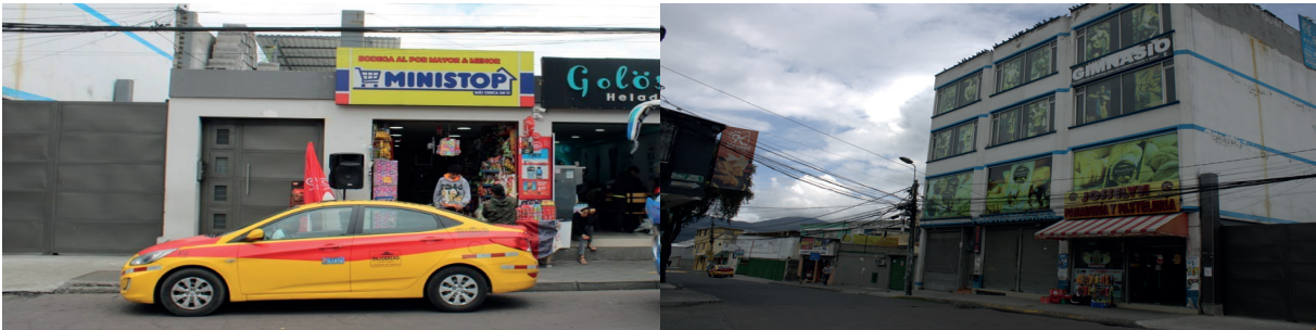
Figura 39. Observación - Cerramientos en planta baja
