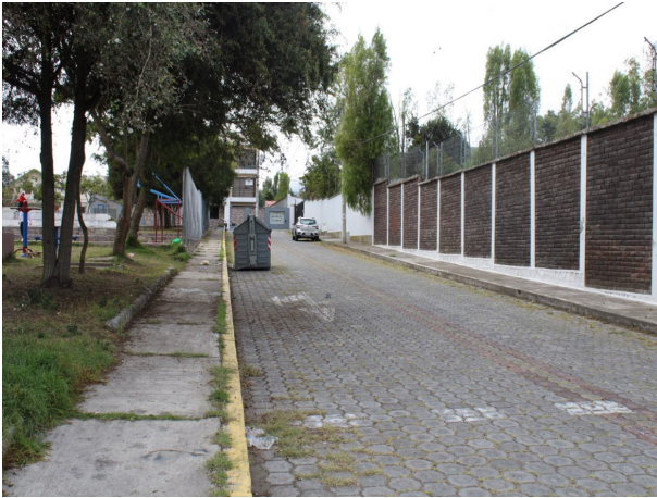
Figura 109. Observación - Cerramientos en planta baja
