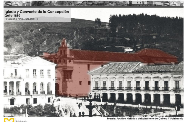
Figura 2. Iglesia de la concepción, repositorio INPC.
