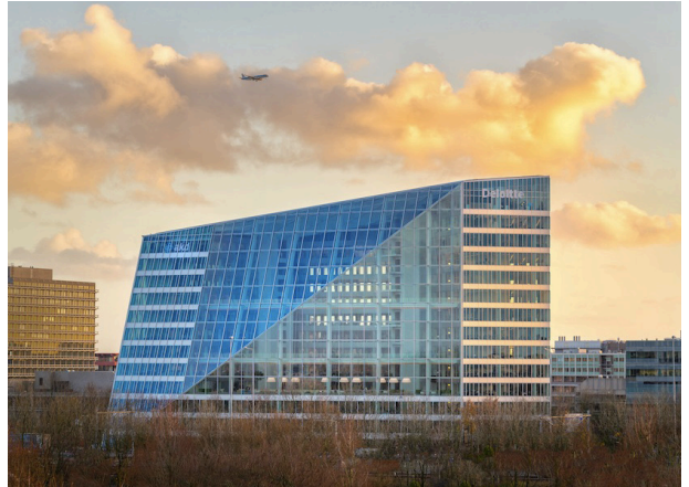
Fig 5: Edificio The Edge Fuente: Basulto y Assael, (2020)
