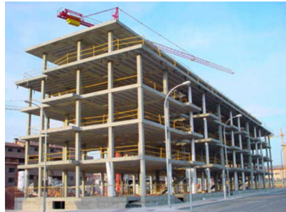
Figura 4 Edificio en hormigón Fuente: ARQHYS
