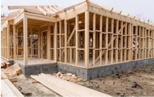
Figura 9 Edificio realizado con sistema de plataforma Fuente: Madera21
