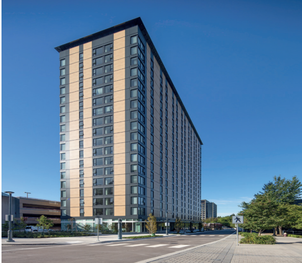
Fig 12. Edificio de Altura de madera Crédito: Acton Ostry Architects Fuente, (Acton Ostry,.2017)
