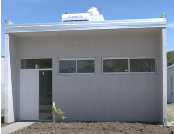
Figura 29 Vivienda terminado con sistema de steel framing Fuente: Disser, Distribución y servicios para la construcción.
