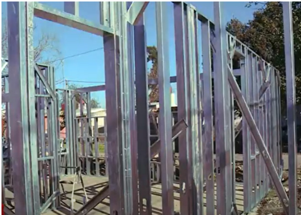
Figura 25 Vivienda, Muro con sistema steel framing Fuente: Disser, Distribución y servicios para la construcción.
