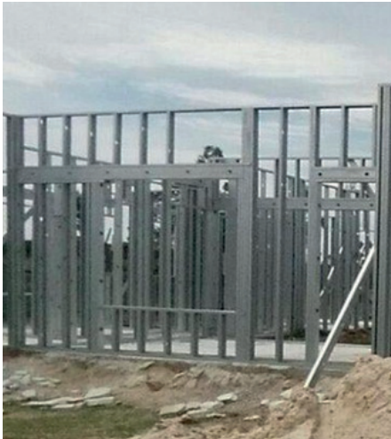
Figura 32 Vivienda estructura con sistema de steel framing Fuente: Steel Framing Uruguay.
