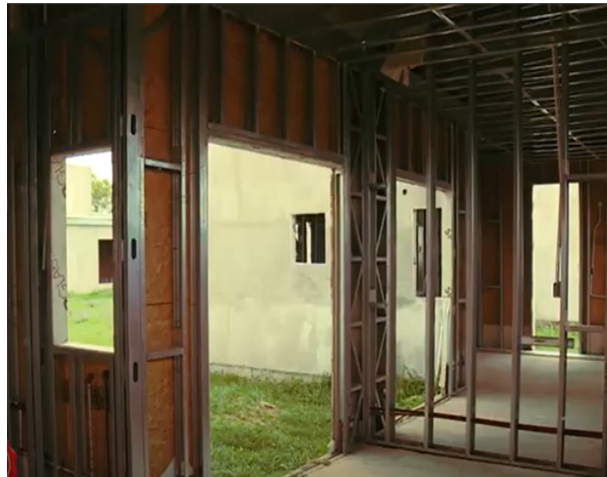
Figura 27 Vivienda, Paneles con sistema steel framing Fuente: Disser, Distribución y servicios para la construcción.
