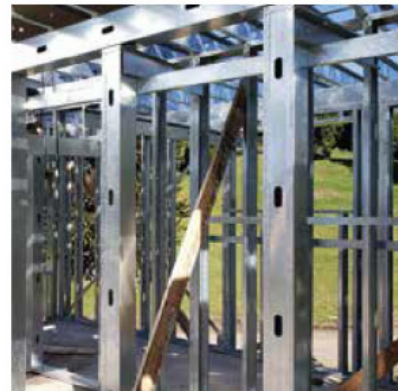
Figura 14 Muro estructura de steel framing
