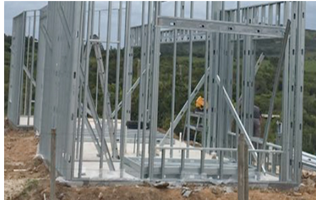
Figura 31 Vivienda estructura con sistema de steel framing Fuente: Steel Framing Uruguay.
