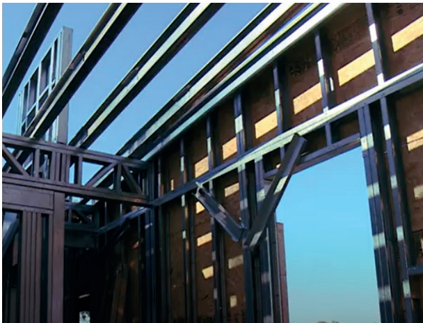
Figura 26 Vivienda realizado con sistema steel framing Fuente: Disser, Distribución y servicios para la construcción.
