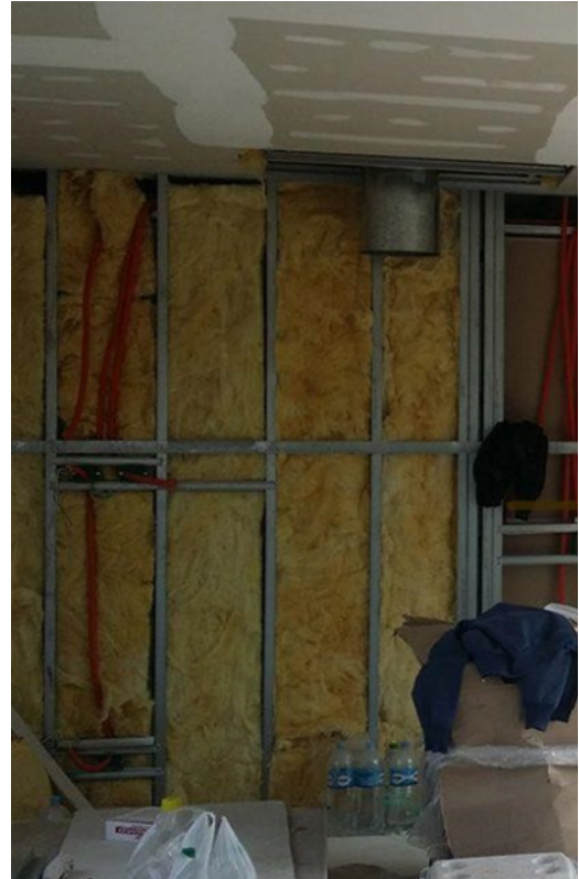
Figura 33 Vivienda Paneles con sistema de steel framing Fuente: Steel Framing Uruguay.
