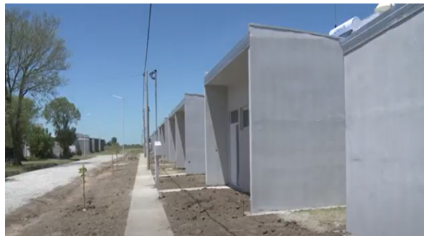
Figura 28 Vivienda terminado con sistema de steel framing Fuente: Disser, Distribución y servicios para la construcción.
