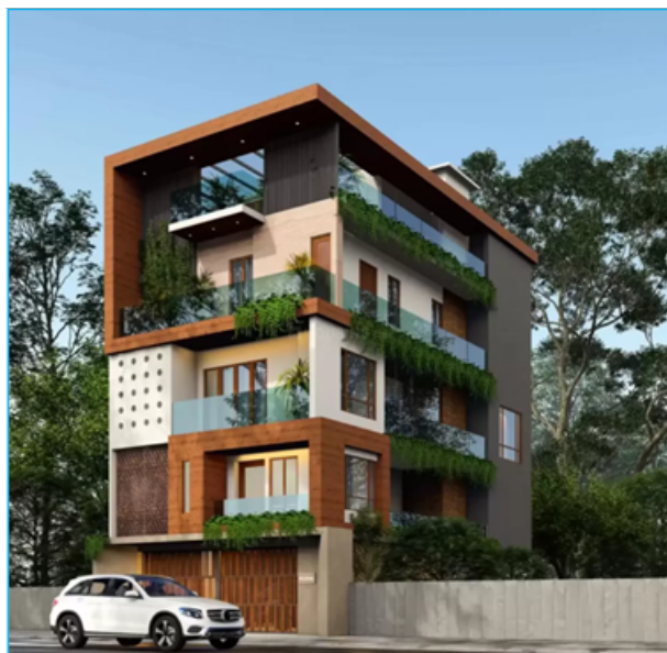
Figura 31: Fachada Principal. Casa VV Aura - India. Fuente: EDGE, 2021
