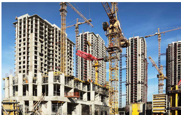
Fig. 4 Construcción de Concreto.
