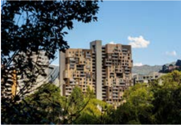
Fig. 20: Vivienda Multifamiliar Ventum Fuente: Archdaily, 2023
