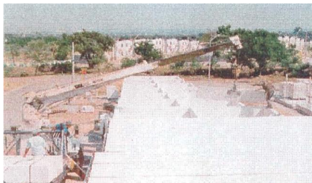
Gráfico 68: Construcción de 7000 viviendas en Chihuahua México. Fuente: Arq. Arturo Lechuga
