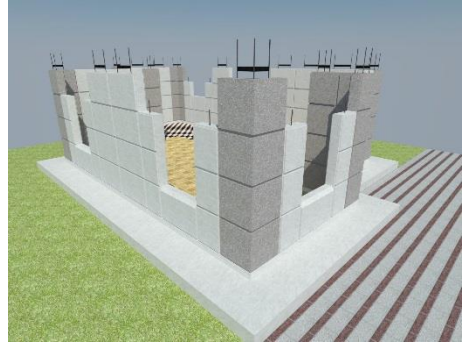
10.- muros portantes laterales planta baja.
