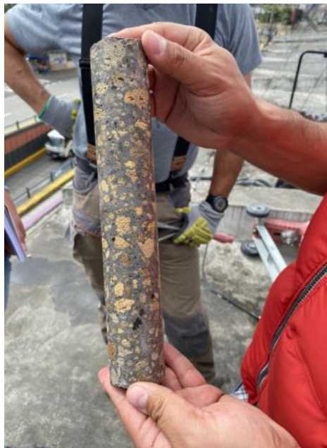
Ilustración 1 Muestra para realizar pruebas de resistencia de hormigón de las vigas de la tribuna del estadio Bellavista de Ambato. Fuente: Propia
