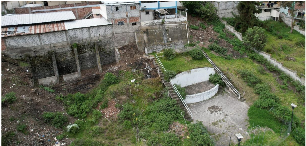
Gráfico N° 22. Zona de deslizamiento pasivo rotacional
