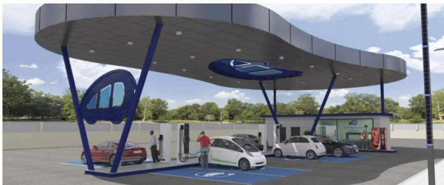
Figura 2.-Electrolinera para la recarga de vehículos eléctricos.
