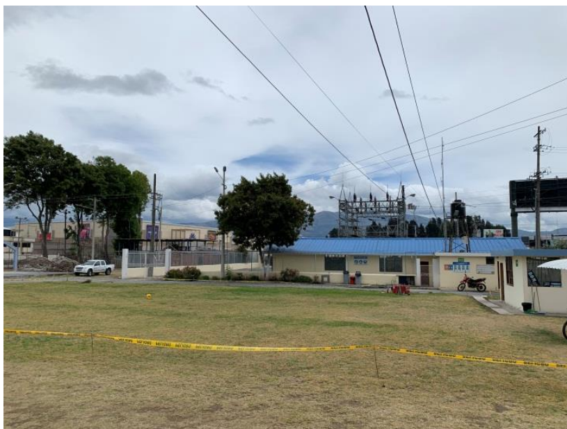
Figura 14.- Subestación 2 Empresa Eléctrica Riobamba S.A.
