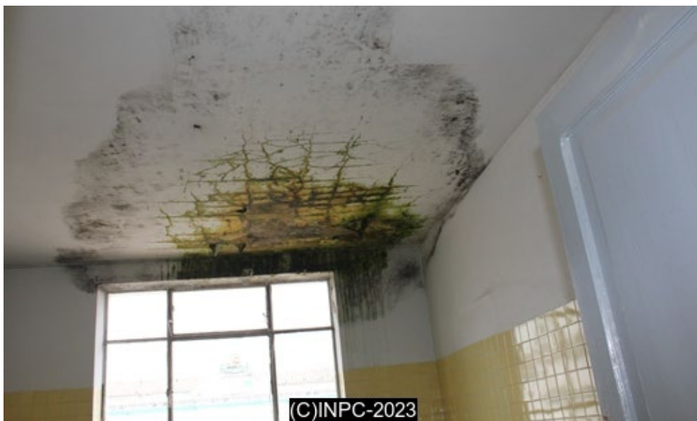
Imagen 18. Interior del Antiguo Hospital de Indígena IESS Latacunga.
