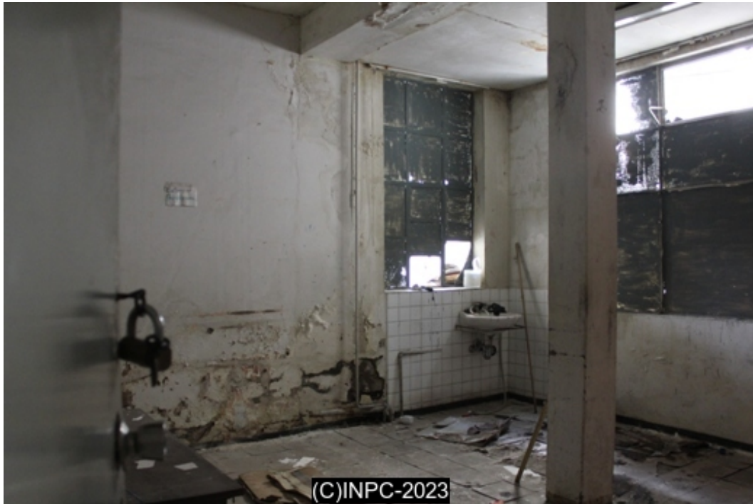
Imagen 16. Interior del Antiguo Hospital de Indígena IESS Latacunga.
