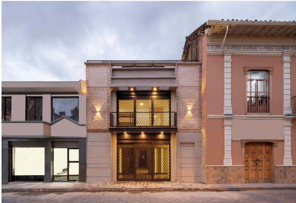
Imagen 8. Evidencia fotográfica de la Casa de los Pórticos
