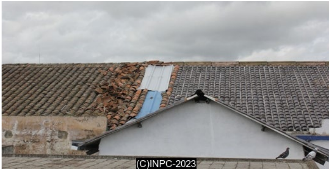
Imagen 17. Cubierta del Antiguo Hospital de Indígena IESS Latacunga.
