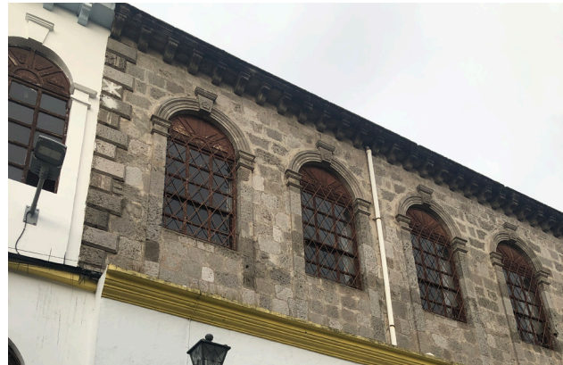
Figura 6 Muro de piedra
