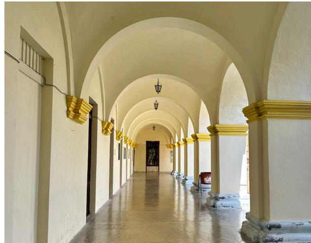
Figura 33 Arco de medio punto y bóveda de vaída del Ala Sur Colegio
