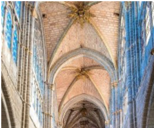
Figura 16 Bóveda de crucería. Catedral de Cristo Salvador.
