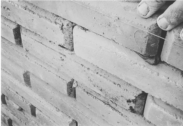
Figura 5 Colocación de ladrillo
