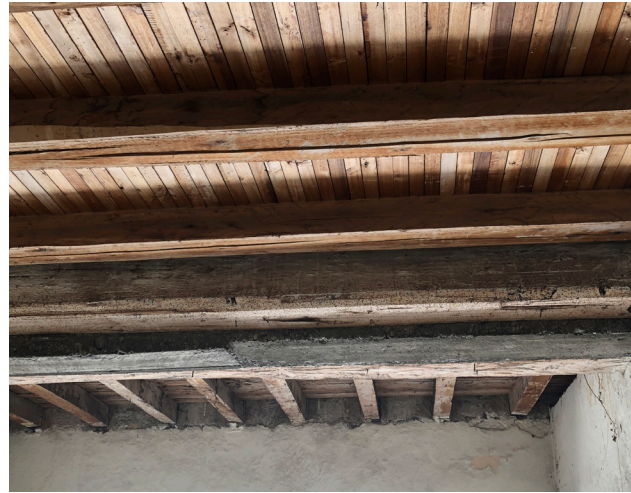
Figura 32 Sistema constructivo losa entrepiso
