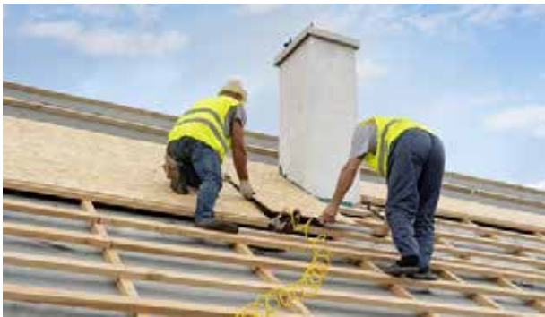
Fig. Tableros OSB en techos.
