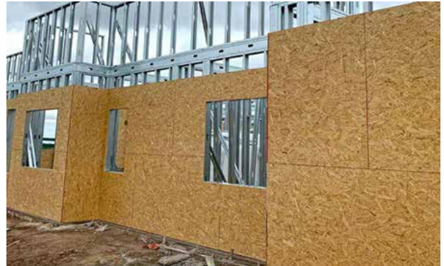
Fig. Tableros de OSB en muros.
