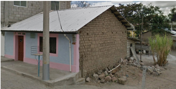
Imagen 59. Construcciones de Adobe en Lumbisí.
