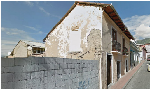
Imagen 51. Construcciones de Adobe en El Tejar.
