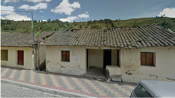
Imagen 62. Construcciones de Adobe en Nono.
