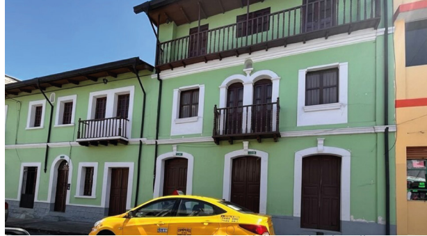
Imagen 44. Construcciones de Adobe en Chimacalle.
