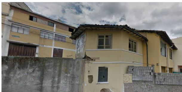
Imagen 75. Construcciones de Adobe en Toctiuco.
