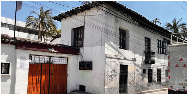
Imagen 43. Construcciones de Adobe en Chillogallo.
