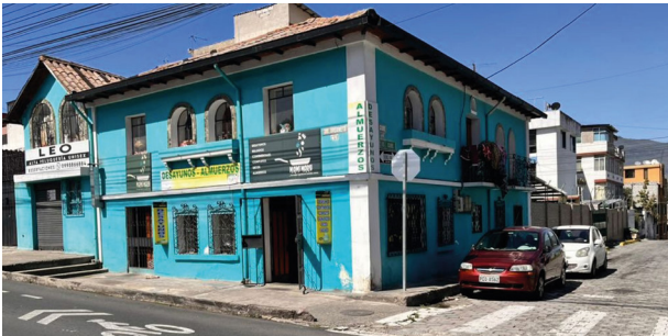
Imagen 67. Construcciones de Adobe en San Bartolo.
