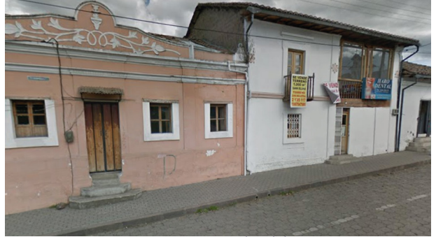
Imagen 64. Construcciones de Adobe en Pintag.
