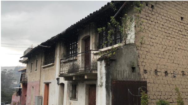
Imagen 38. Construcciones de Adobe en Amaguaña.
