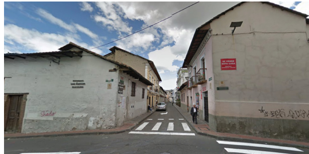
Imagen 69. Construcciones de Adobe en San Marcos.
