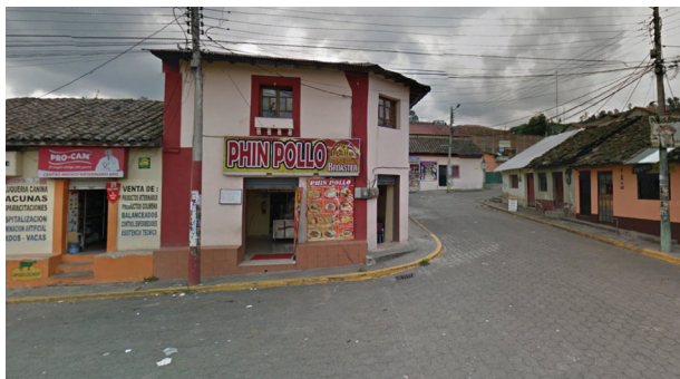
Imagen 74. Construcciones de Adobe en Tambillo.
