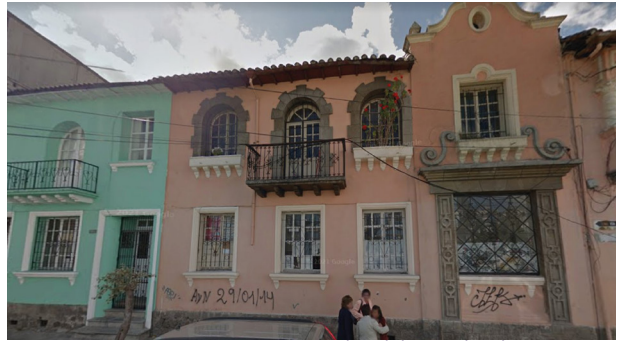
Imagen 48. Construcciones de Adobe en El Ejido.
