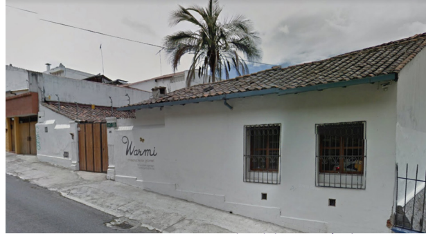
Imagen 52. Construcciones de Adobe en Guápulo.
