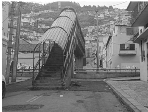
Figura 11: Puente peatonal calle Ambato
