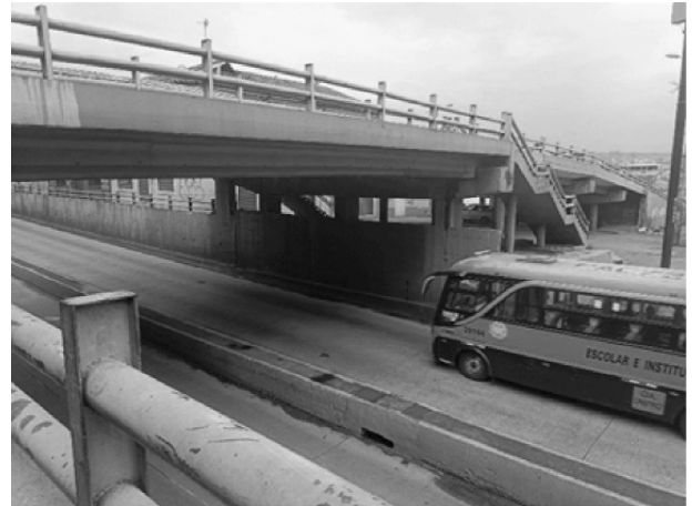
Figura 2: Paso elevado calle Abdón Calderón Fuente: Elaboración propia
