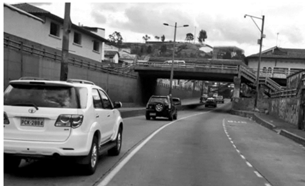
Figura 7: Paso elevado calle Abdón Calderón Fuente: Elaboración propia
