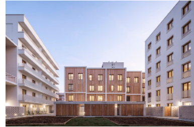
Figura 29. Patios Interiores de la Courneuve (Francia). Fuente: ArchDaily Colombia, (2019).
