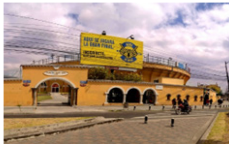
Figura 35. Plaza de Toros. Fuente: Taller de Aplicación Avanzada, 2022
