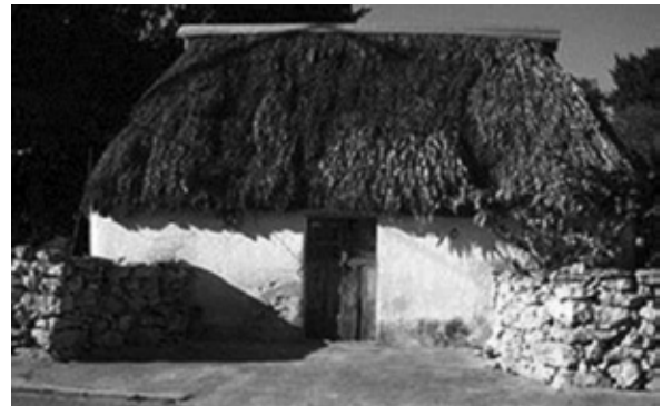
Figura 12: Casa Maya con muros de embarro en la región de Yucatán Fuente: (Gonzales & Fuentes, 2012)
