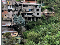
VIVIENDAS EN ALTO RIESGO
