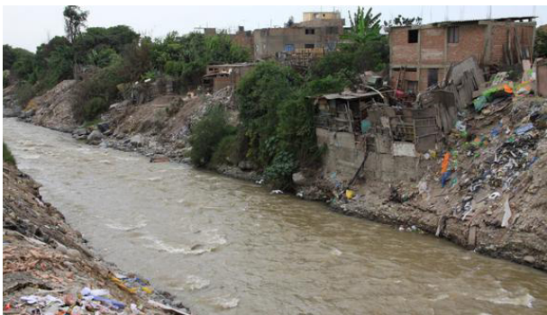
Figura 2 Viviendas en riesgo al borde de quebrada en Trujillo, Perú Fuente: (La Libertad, 2019)
