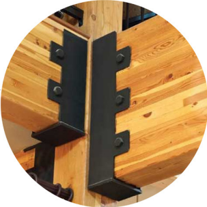
MADERA LAMINADA UNIONES CON PERNOS
