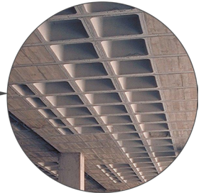
CASATON RECUPERABLE HORMIGÓN ESTRUCTURAL EN SUBSUELO
