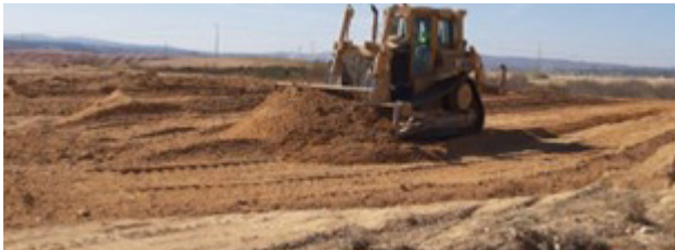
Figura 10. Extracción y movimiento de tierras
