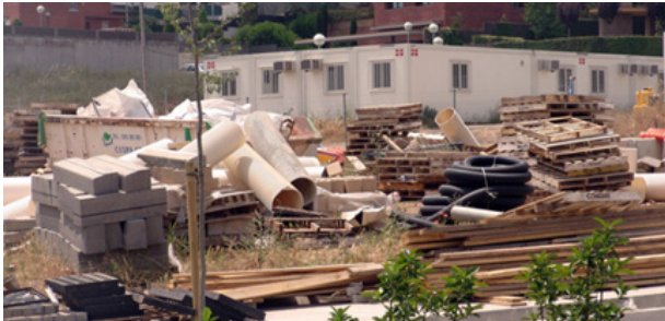
Figura 3. Desechos causados por la construcción
