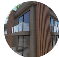
FACHADA FIBROCEMENTO DE MADERA LAMINADA CON RECUBRI- MIENTO DE PANEL ETERNIT
