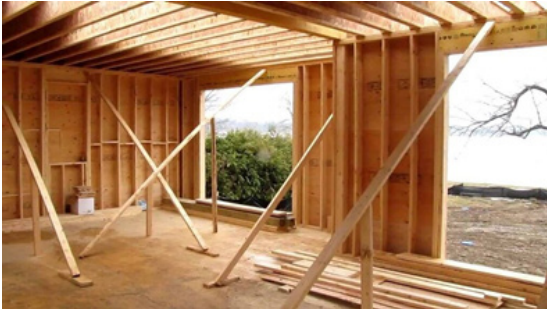
Imagen 15.Sistema Wood Frame
