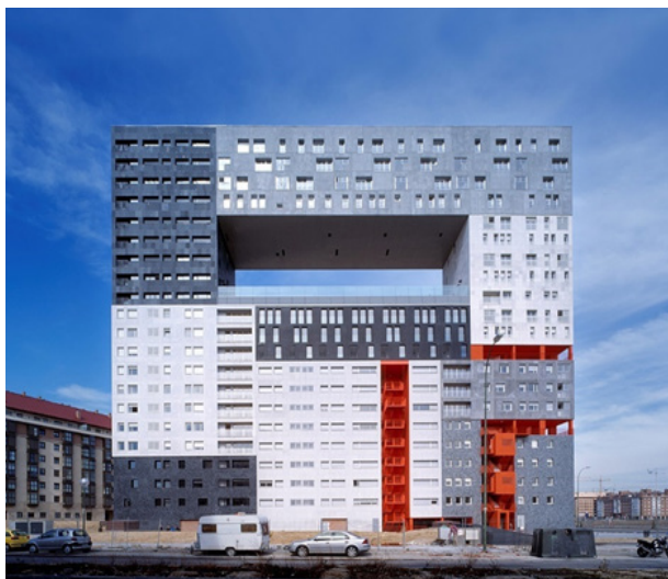
Fig. 12 Fotografía del Edificio Mirador Fuente. 12 MVRDV
