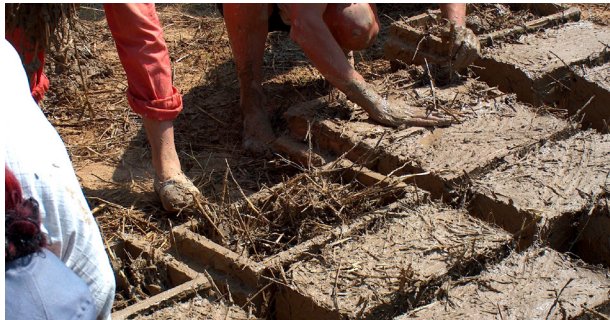
Diagrama 12. Proceso de fabricación del Adobe Fuente: Elaboración Propia (2022)
