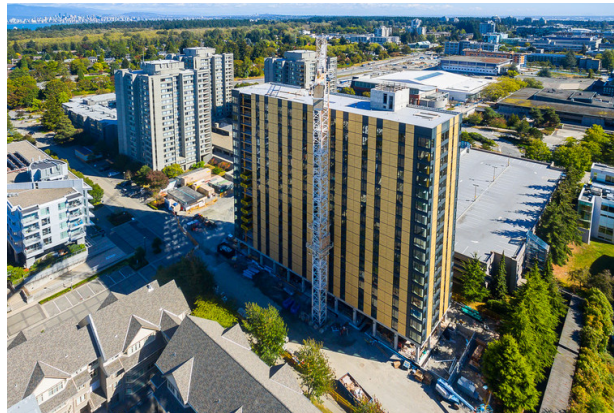
Imagen 26. Brock Commons Fuente: (Hasan, 2022)
