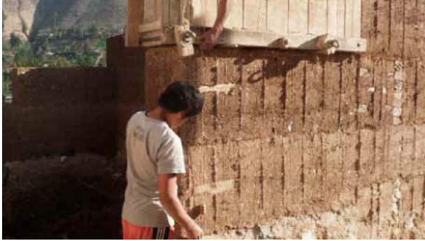
Imagen 13. Construcción de Tapial
