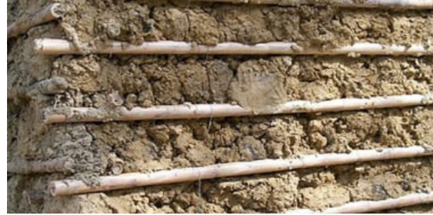
Imagen 19. Construcción de Bahareque
