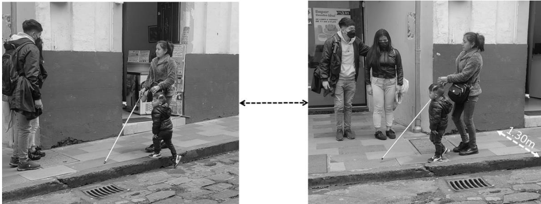
Figura 13. Acera intervenida de la Calle Quito, sin aplicación de Diseño Universal Acera intervenida de la Calle Quito, sin aplicación de Diseño Universal
