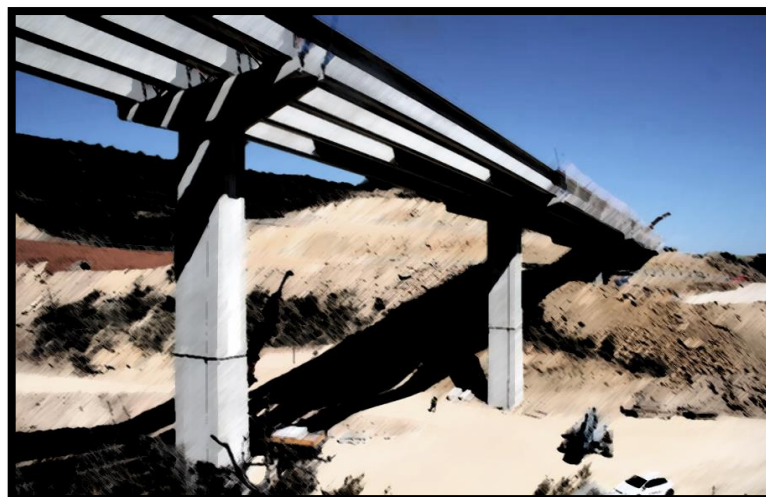
Imagen 68: Prefabricado en taller de un puente
