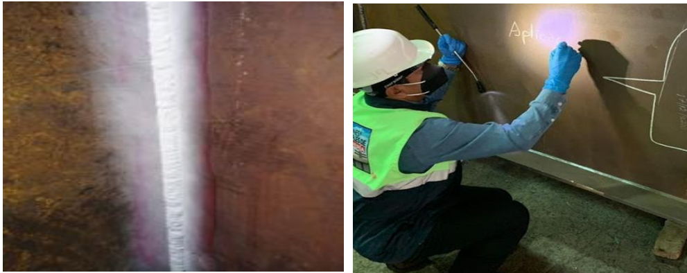
Imagen 103: Inspección de almas Elaborado por: Moreno, Wilson (2022)
