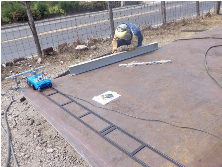
Imagen 32: Trazado de plancha según camber Elaborado por: Moreno, Wilson (2022)
