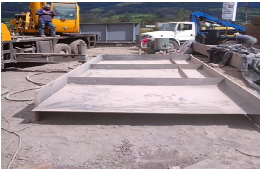
Imagen 44: Samblasteada de la estructura al 100% Elaborado por: Moreno, Wilson (2022)
