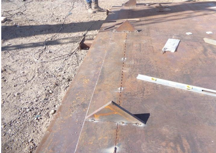
Imagen 33: Planchas unidas para cortar alma Elaborado por: Moreno, Wilson (2022)
