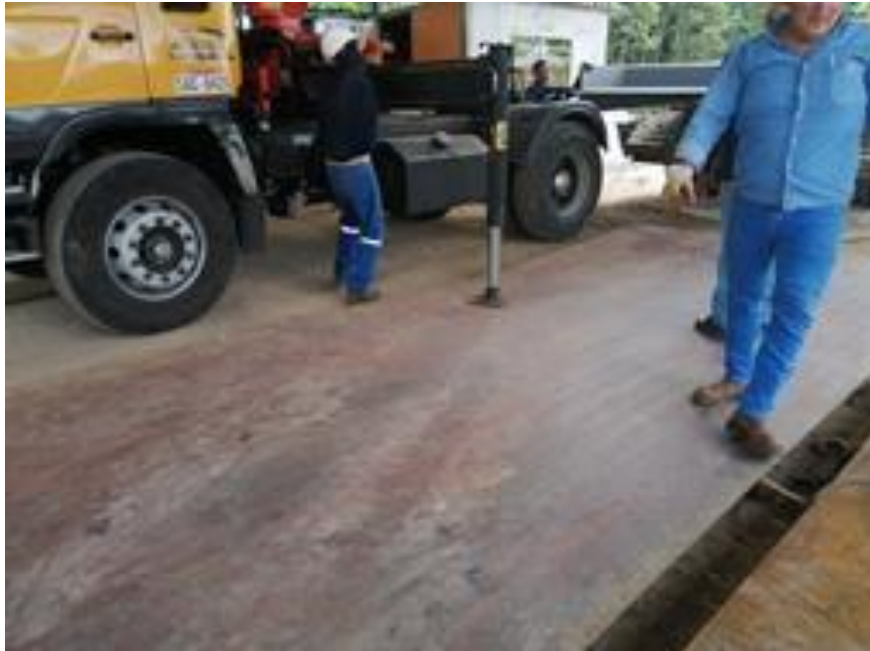
Imagen 45: Samblasteing de vigas limpias Elaborado por: Moreno, Wilson (2022)
