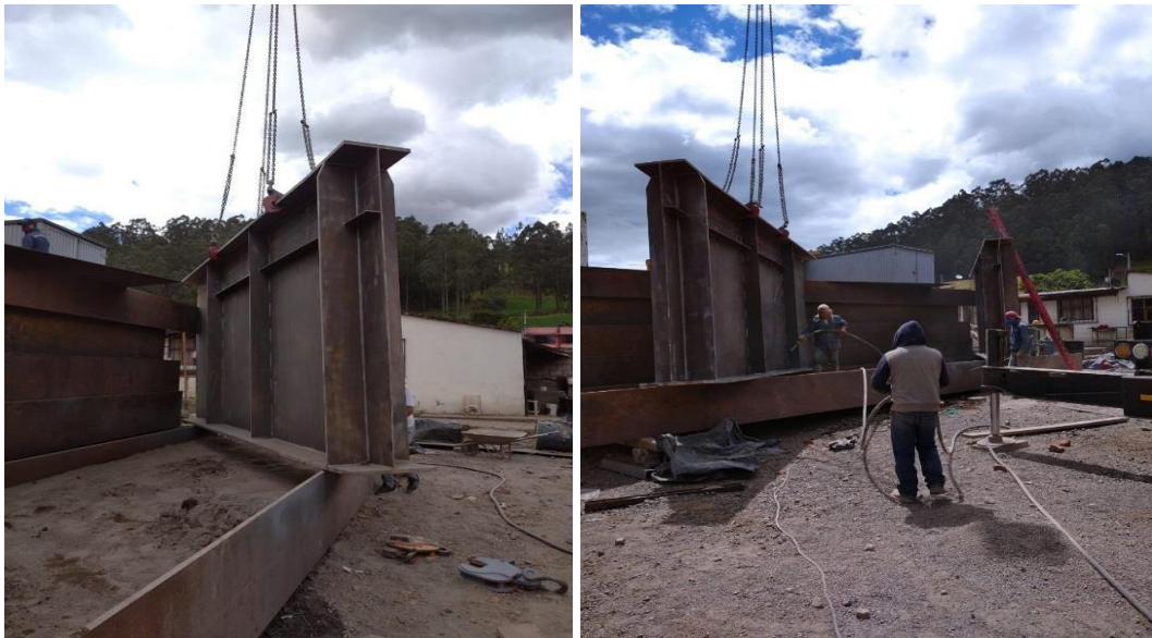
Imagen 42: Dovelas con rigidez horizontales y verticales aplicados con simetría Elaborado por: Moreno, Wilson (2022)
