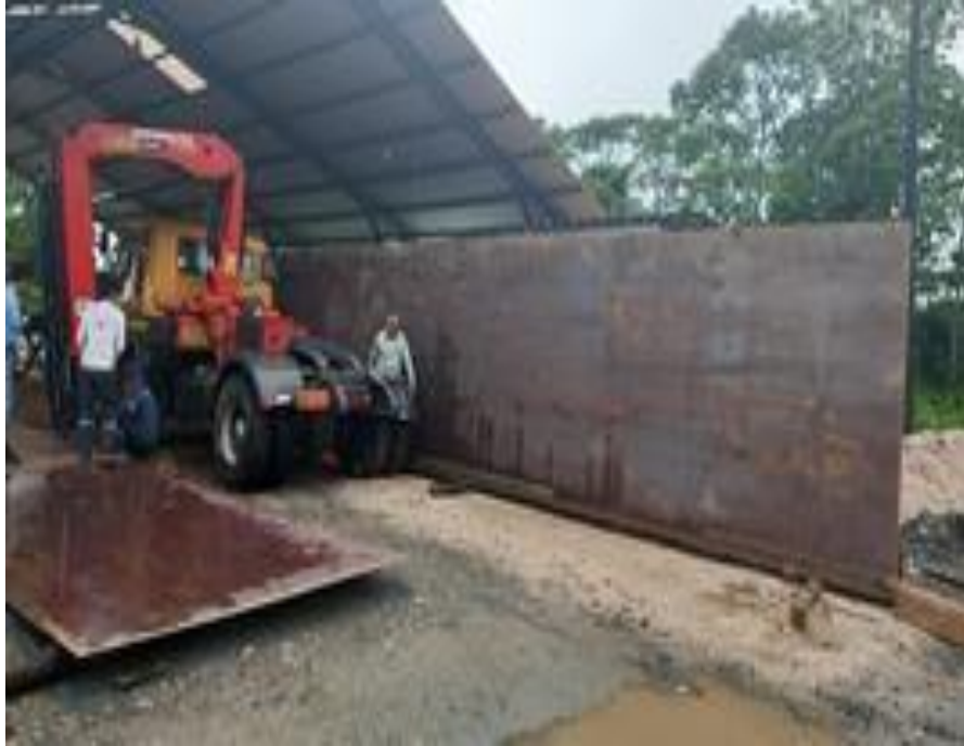
Imagen 31: Montaje de patín inferior Elaborado por: Moreno, Wilson (2022)
