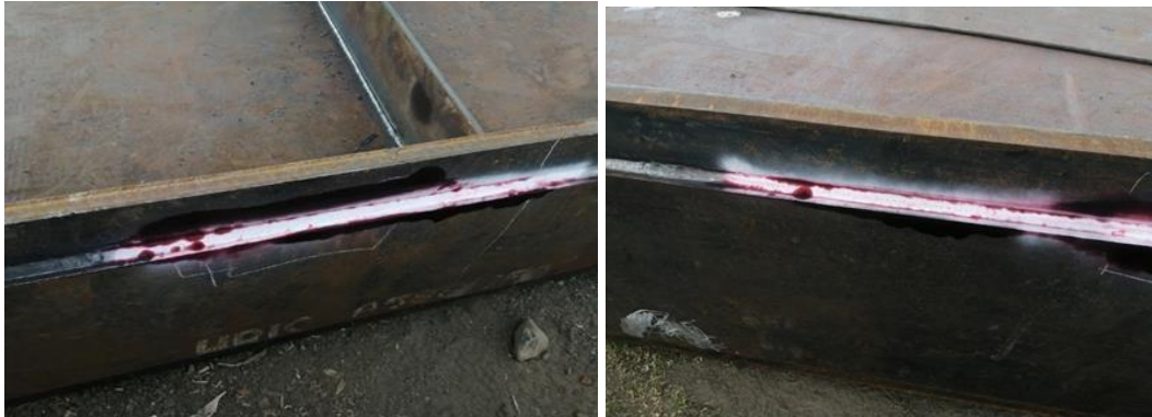
Imagen 107: Inspección de cordones de fileteados Elaborado por: Moreno, Wilson (2022)
