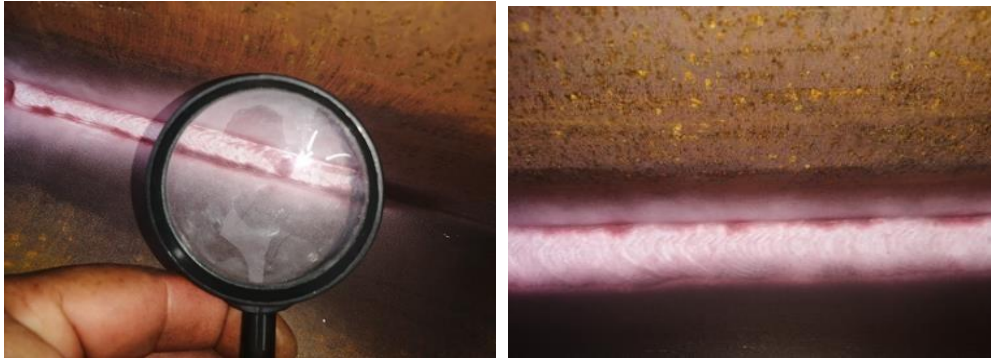
Imagen 100: Inspección de filetes Elaborado por: Moreno, Wilson (2022)
