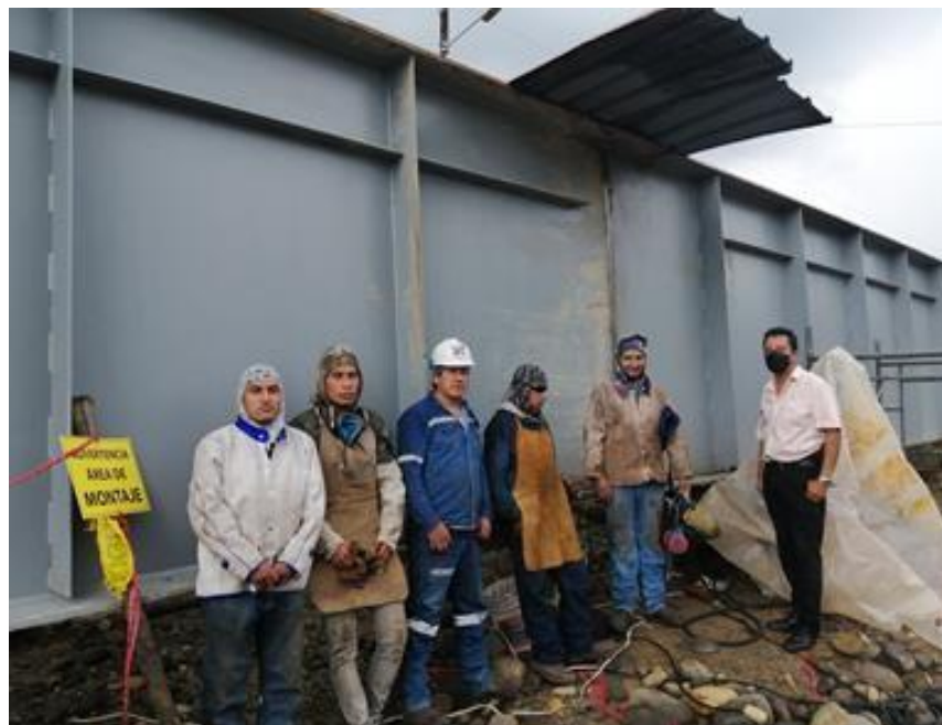
Imagen 48: Armado de vigas longitudinales Elaborado por: Moreno, Wilson (2022)
