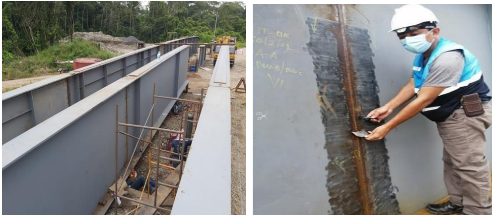
Imagen 112: Inspección de unión de dovelas Elaborado por: Moreno, Wilson (2022)
