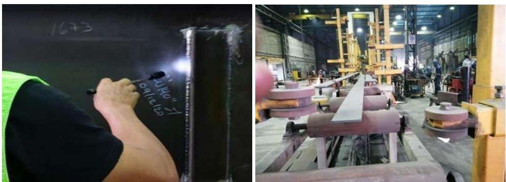
Imagen 99: Inspección de filetes, almas Elaborado por: Moreno, Wilson (2022)
