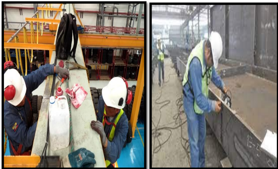
Imagen 24: Inspección de soldadura Fuente: (LABSOL, 2022)
