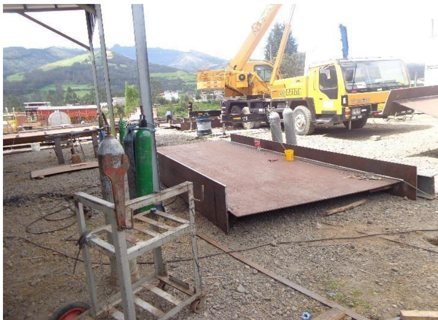
Imagen 40: Armado del patín superior e inferior Elaborado por: Moreno, Wilson (2022)
