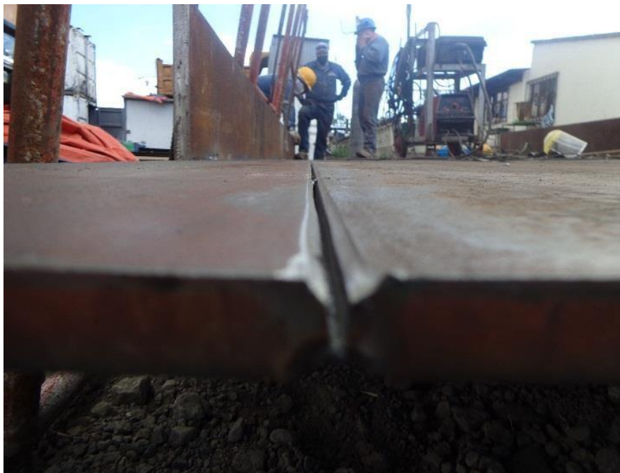
Imagen 36: Control del biselado con los ángulos 60° - 30° C/L Elaborado por: Moreno, Wilson (2022)
