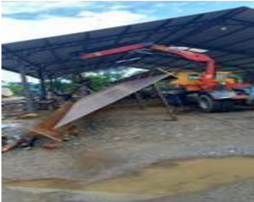
Imagen 43: Limpieza dovela samblasting Elaborado por: Moreno, Wilson (2022)
