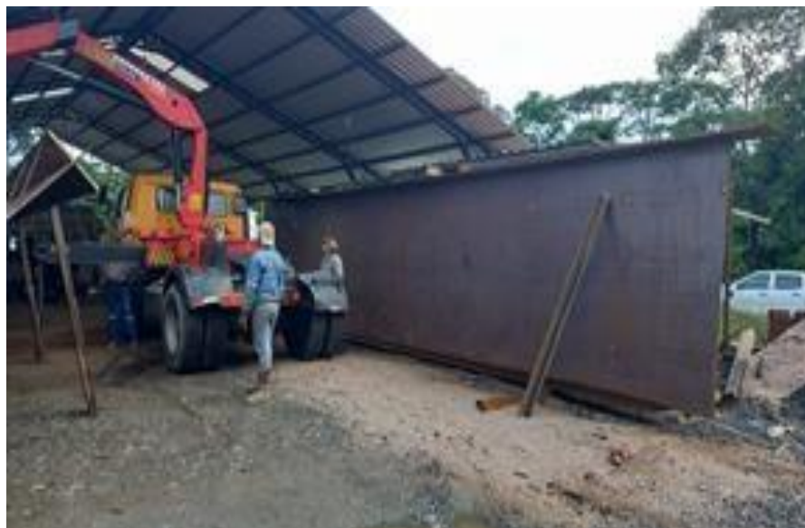
Imagen 38: Alineación simétrica de alma para preparación de la soldadura Elaborado por: Moreno, Wilson (2022)
