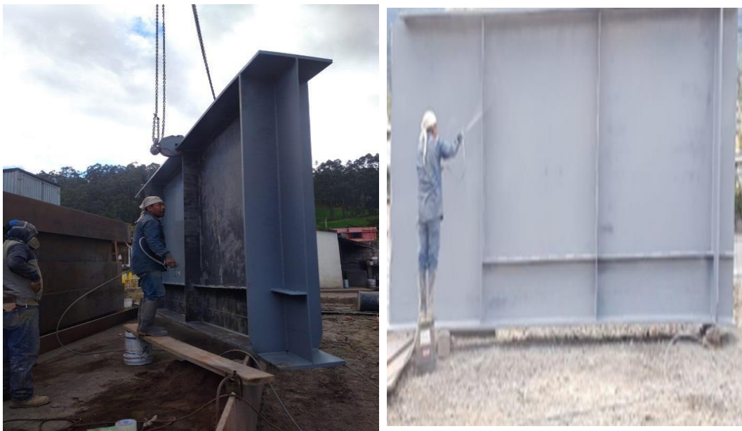
Imagen 46: Aplicación de pintura anticorrosiva para dovela Elaborado por: Moreno, Wilson (2022)
