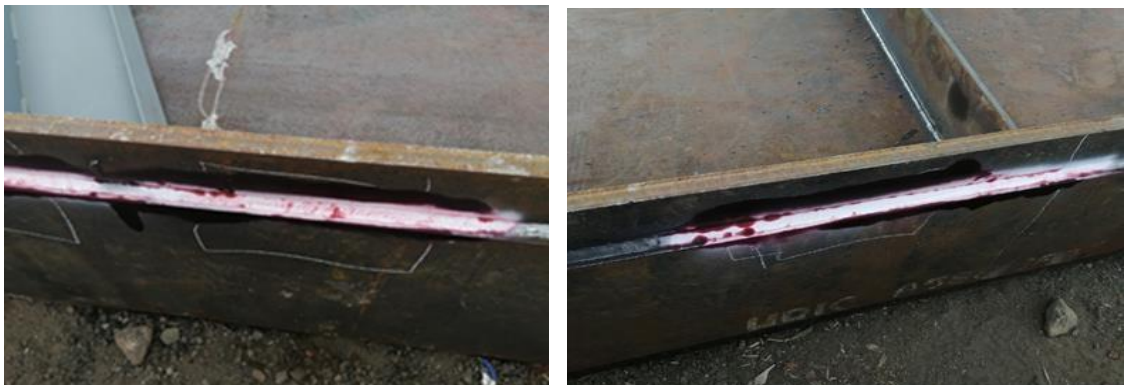
Imagen 106: Inspección de refuerzos en patines inferiores Elaborado por: Moreno, Wilson (2022)
