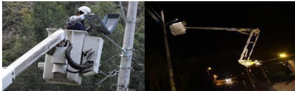
Imagen 3: Reemplazo de control fotoeléctrico en luminarias
