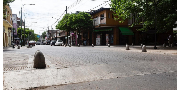
Figura 65 Veredas y calzada al mismo nivel
