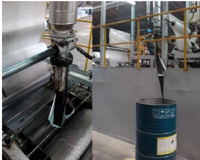
Figura 29: Desalojo de mezcla dañada de tuberías
