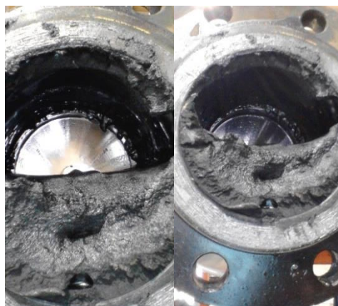
Figura 28: Polímero gelificado en líneas de tubería
