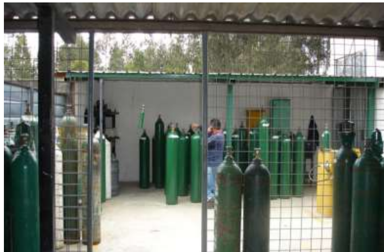
Figura 19 Alternativa 1: antes, cilindros en desorden en el área de llenado
