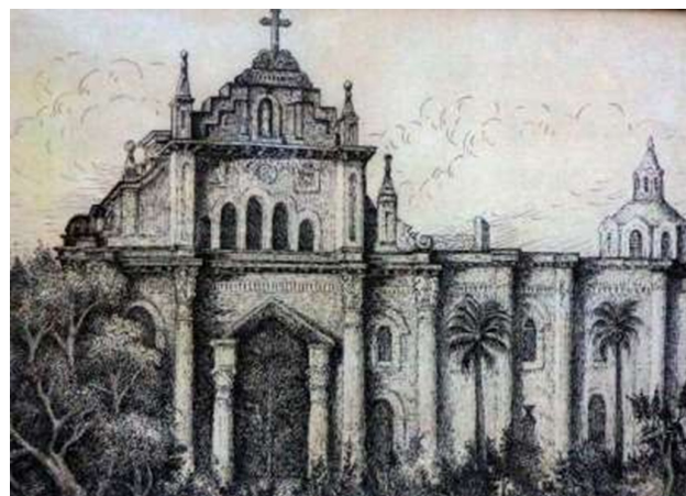
Figura 14 Iglesia Matriz antes del terremoto (1986).
