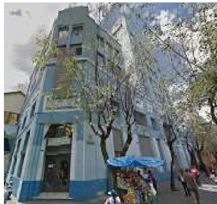
Figura 4 Edificio La Previsora Centro
