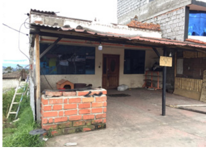
Figura 9 Vivienda construida con un sistema convencional
