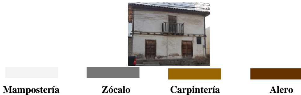
Vivienda de 2 niveles
