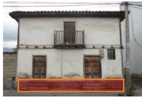
Cimentación con piedra Pishilata
