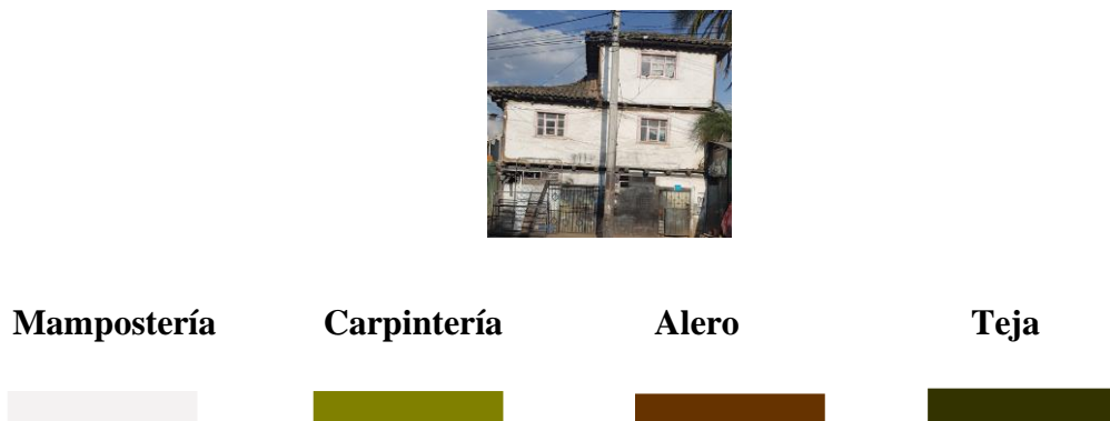
Vivienda de 3 Niveles
