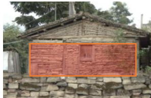
Muros de adobe y carrizo
