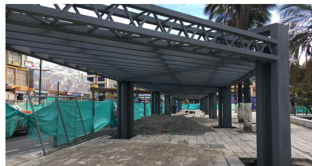
Figura 6. Intervenciones del 2021 del Parque 12 de Noviembre / parada de bus.
