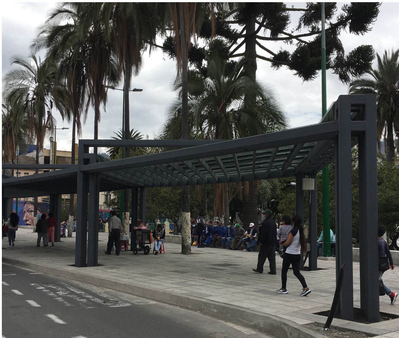
Figura 46. Paradas intermodales del Parque 12 de Noviembre, año 2021.
