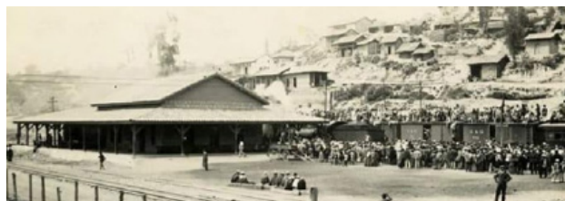
Figura 23. Estación del tren de la ciudad de Ambato, año 1910-1912.
