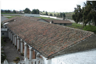
Descripción:Detalle de la cubierta en teja
