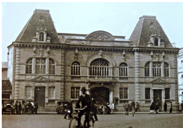
Figura 3 Antigua biblioteca Nacional de Quito, actualmente derrocada
