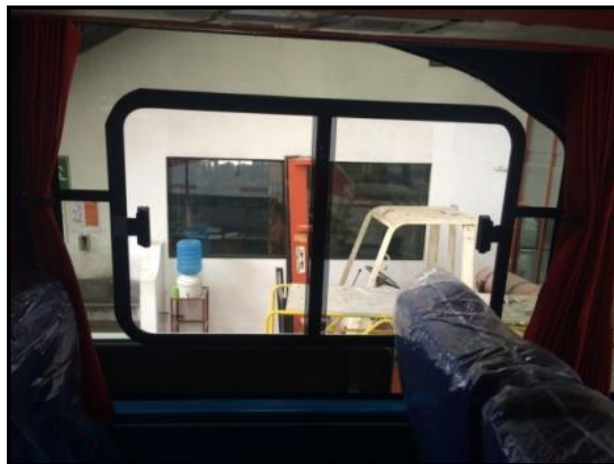
Figura N° 70: Inspección de ventanas de usuarios Elaborado por: Investigador
