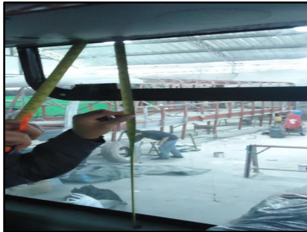
Figura N° 55: Medición de altura de la ventana lateral Elaborado por: Investigador
